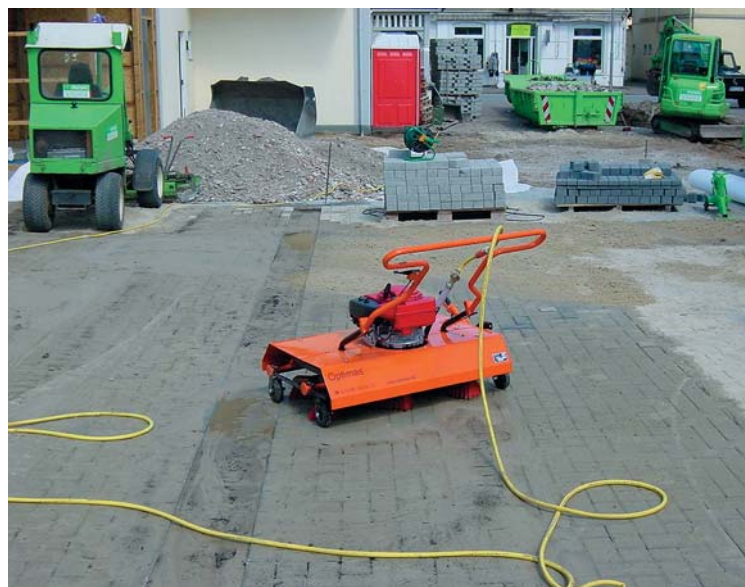
Mit Wasserschlauch war die Handhabung komplizierter.
