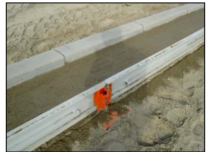
...fertig ist das Fundament.
