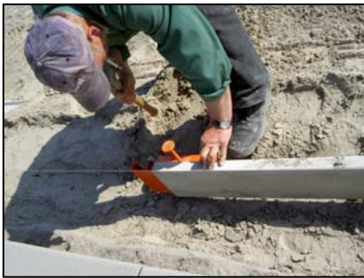
Aufbauen und einnivellieren,...
