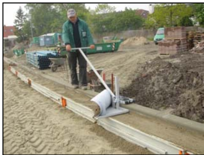
...mit dem Betonhobel abziehen,...
