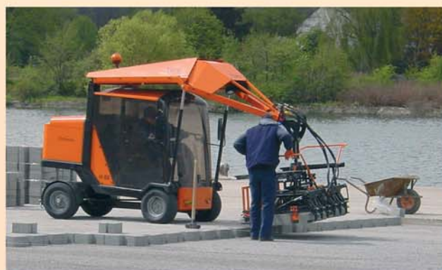
Langlebigkeit von Chassis und Ausleger auch bei extremer Dauerbelastung (s. Bild Pflastersteinlage 1,2 m 2 mit Steinhöhe 13 cm - Gewicht ca. 350kg)
